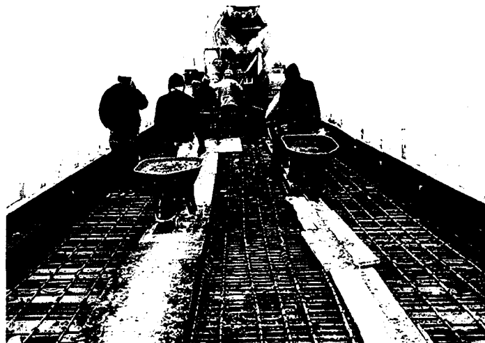
FOTO 02: Vaciado de concreto en losa del día 03/07/19
