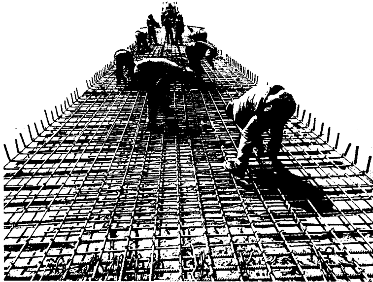
FOTO 01: Armado de acero en losa del día 01/07/19
